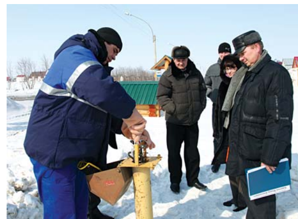
Александр Вихляев, инженер I категории отдела ЭХЗ ОАО «Тамбовоблгаз», производит электроизмерение на контрольно-измерительном пункте
