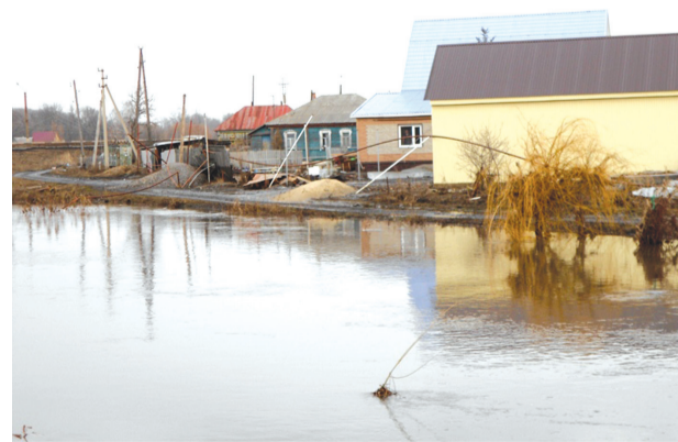
Повреждённый газопровод низкого давления по ул. Набережной г. Уварово
