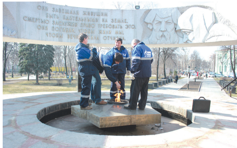
Специалисты службы промышленных предприятий: слесарь по эксплуатации и ремонту газового оборудования 5-го разряда Владимир Меляков, мастер Алексей Дмитриев, слесарь по эксплуатации и ремонту газового оборудования 4-го разряда Владимир Бадин, слесарь по эксплуатации и ремонту газового оборудования 4-го разряда Юрий Шлыков проводят техническое обслуживание мемориала «Вечный огонь»
