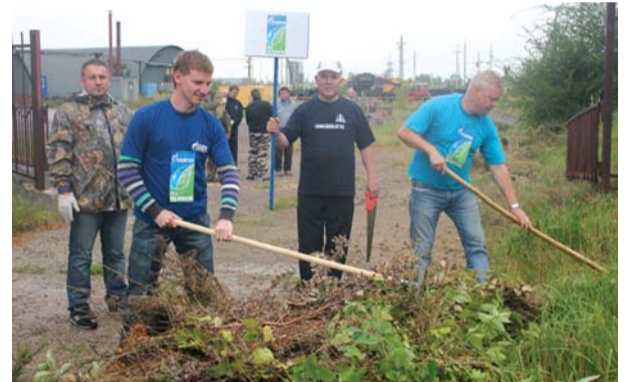
Сотрудники центрального офиса ОАО «Тамбовоблгаз» проводят очистку охранной зоны газопровода в с. Бокно Тамбовского района
