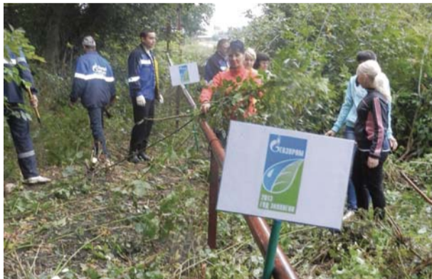
Сотрудники «Уваровмежрайгаз» филиала ОАО «Тамбовоблгаз» проводят очистку охранной зоны газопровода низкого давления по ул. Энгельса для проведения покрасочных работ в дальнейшем
