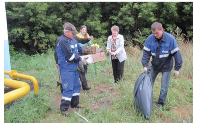
В ходе акции сотрудники «Рассказовмежрайгаз» филиала ОАО «Тамбовоблгаз» провели очистку охраняемых зон ГРП №№ 9, 13, 14, 15, 20, 22, 24, 26 и № 4 Бондарского газового участка № 23 в с. Вердеревино
