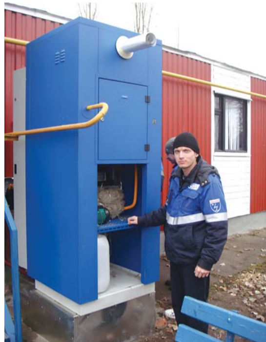
Практическое обучение на объекте с газопользующим оборудованием Viessmann
