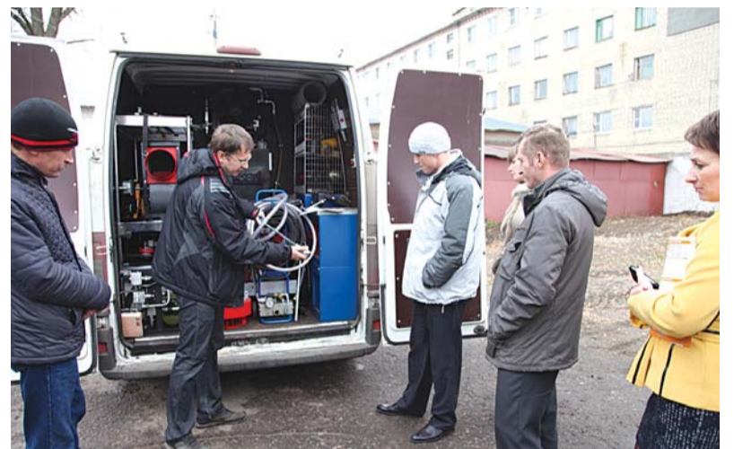
Демонстрация гидрофицированного автомобиля и набора инструментов для устранения аварий и проведения ремонтных работ на сетях производства
