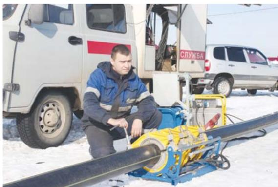
Андрей Нахватов, оператор машин контактной сварки РСУ филиала «Расказово межрайгаз» ОАО «Газпром газораспределение Тамбов» производит монтаж полиэтиленовых труб для газификации микрорайона «Гвардейский» (март 2013 г.)
