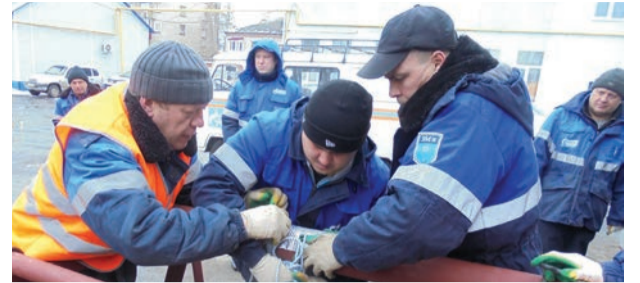
Устранение утечки газа с помощью экспериментальных материалов. Слесари аварийно-восстановительных работ АДС Юрий Щербаков, Павел Нестеров, Игорь Куркин
