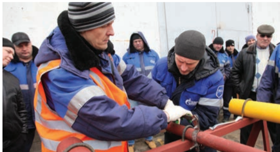
Устранение утечки газа при полном разрыве трубы с помощью заглушки и фиксирующего устройства. Мастер АДС Сергей Арчаков, слесарь аварийно-восстановительных работ Максим Махонин
