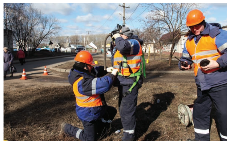
Подготовка к спуску в условно загазованный газовый колодец
