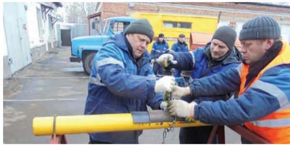
Устранение утечки газа при помощи струбцины. Слесари аварийно-восстановительных работ АДС Алексей Чичканов, Максим Махонин, Юрий Щербаков
