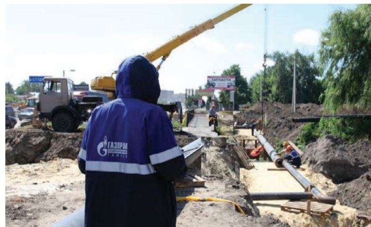
Специалисты филиала в г. Тамбове проводят перекладку газопровода среднего давления через реку Студенец
