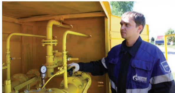
Слесарь по эксплуатации и ремонту подземных газопроводов СПГ и ПП филиала АО «Газпром газораспределение Тамбов» в г. Рассказово Иван Капранов проводит проверку на утечку при текущем ремонте ШРП
