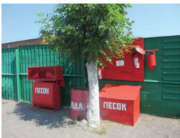
В филиале в г. Рассказово оборудован противопожарный щит
