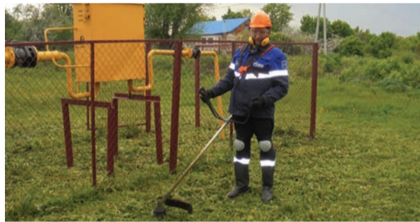
Слесарь СПГ Петровского газового участка филиала АО «Газпром газораспределение Тамбов» в п. Коммунар Михаил Никишин проводит очистку охранной зоны ШРП от дикорастущих растений
