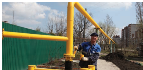
Слесарь по эксплуатации и ремонту подземных газопроводов филиала АО «Газпром газораспределение Тамбов» в п. Коммунар Александр Бреев производит покраску надземного газопровода по ул. Липецкое шоссе г. Мичуринска
