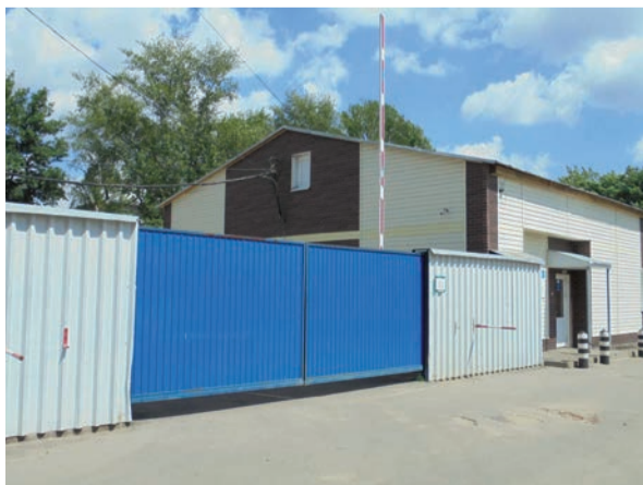
В филиале в г. Тамбове въезд на территорию филиала оборудован автоматическими воротами
