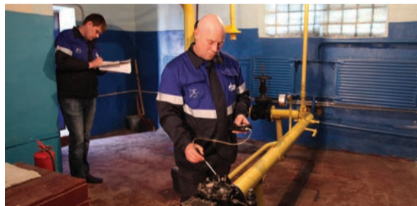
Мастер Дмитрий Зарахович и слесарь по эксплуатации и ремонту газового оборудования Сергей Мордовин СПГ и ПП филиала АО «Газпром газораспределение Тамбов» в г. Тамбове выполняют техническое обслуживание газового оборудования ГРП
