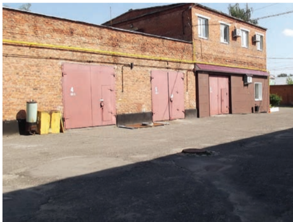
В филиале в г. Котовске территория подметена, отсутствует мусор, ворота гаражных боксов окрашены и пронумерованы
