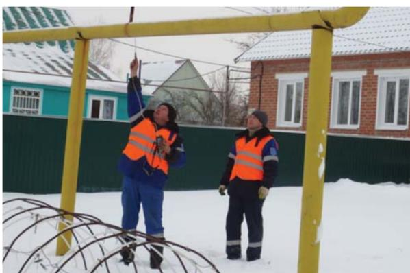
Слесари по эксплуатации и ремонту подземных газопроводов Гавриловского газового участка филиала АО «Газпром газораспределение Тамбов» в г. Кирсанове Виктор Усов (слева) и Юрий Антипов (справа) проверяют герметичность сварного шва на газопроводе низкого давления газоанализатором ФП11, 2 К
