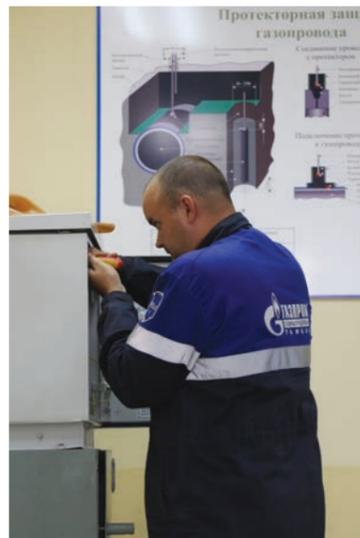
Ремонт станции катодной защиты «Тверца 900»
